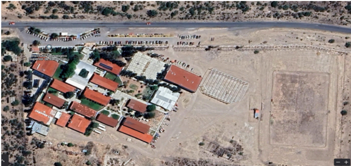
IMAGEN 1. VISTA SATELITAL DE LA DISTRIBUCIÓN DE ÁREAS DE CONSTRUCCIÓN Y ÁREAS VERDES DEL ITSZN.
