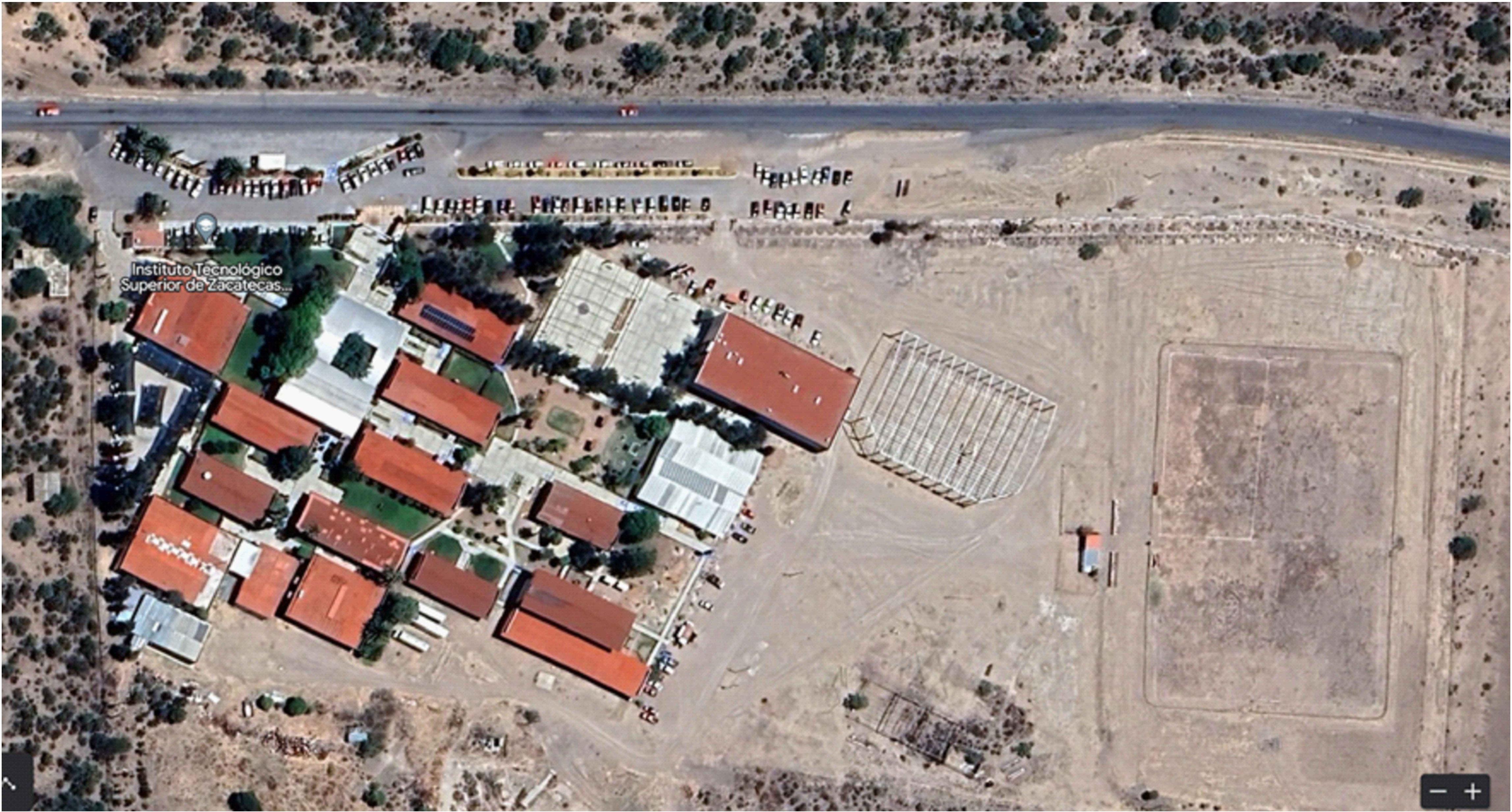
IMAGEN 1. VISTA SATELITAL DE LA DISTRIBUCIÓN DE ÁREAS DE CONSTRUCCIÓN Y ÁREAS VERDES DEL ITSZN.
